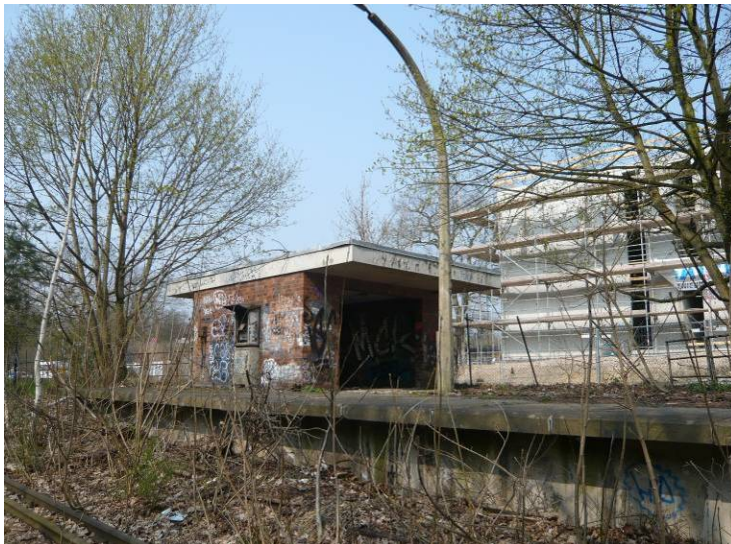
der ehemalige Haltepunkt Zehlendorf-Süd Wetterschutzhaus
