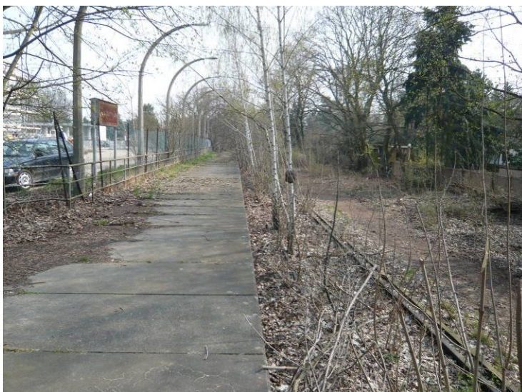
der ehemalige Haltepunkt Zehlendorf-Süd Blick Richtung Zehlendorf
